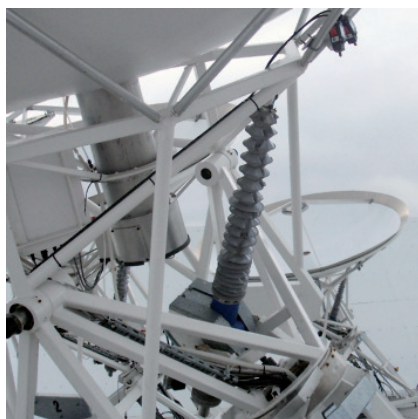
Gruppo di sollevamento antenna.
